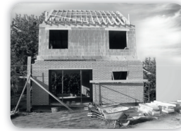
passiehuizen in massiefbouw
