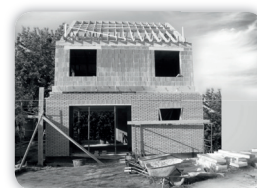
passiehuizen in massiefbouw
