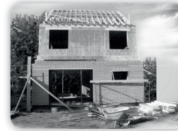
passiehuizen in massiefbouw
