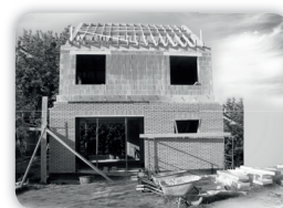
passiehuizen in massiefbouw
