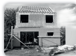
passiehuizen in massiefbouw
