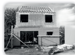
passiehuizen in massiefbouw
