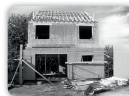
passiehuizen in massiefbouw
