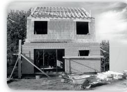
passiehuizen in massiefbouw
